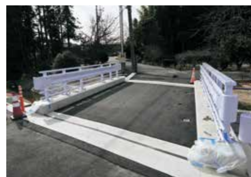
通行が可能となった音羽橋
